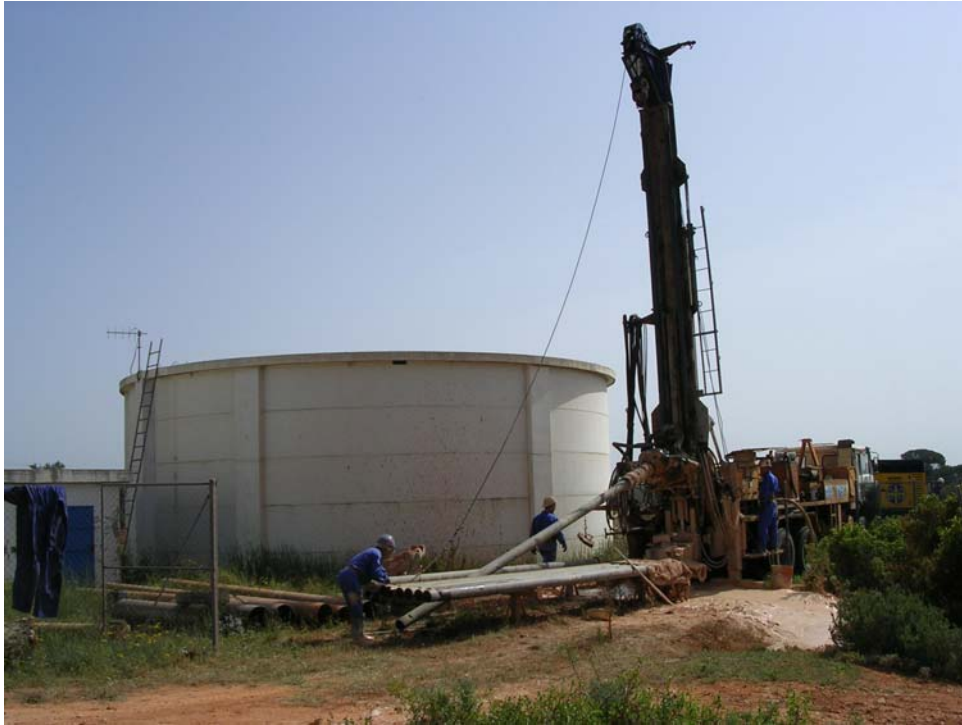
Figura 1- Vistas de la perforación de investigación con rotopercusión del sondeo MOTILLA-II
